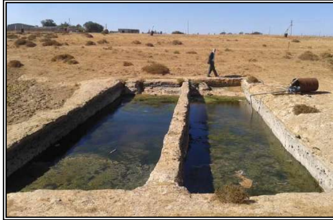
صورة (118): بالجوار الغربي للخزان الظاهر في الصورة (117) السابقة يتجاور هذان الخزانان الطوليان باتجاه شمال-جنوب بطول 16م وعرض الواحد منهما 3م اللذان تزودهما الطبقة الصخرية الجيرية المارنية من منسوب المياه الجوفية السطحية، على طول العام، هذه المياه تتزود منها المنازل المجاورة عن طريق استعمال المضخات الكهربائية، الصفصاف، يمين طريق الأبرق-القيقب، كورفة العجايز، أرض عبد السلام عبد الجواد، الجمعة 21.06.2013، الساعة 16:27.
