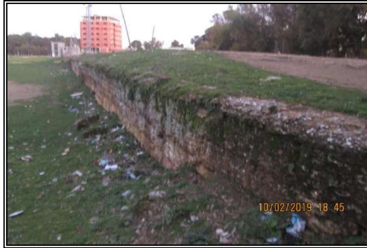
صورة (127): الجدار الجنوبي للخران الكبير المكشوف في منظومة مياه شحات الأثرية، الكاميرا تلتقط الصورة من الزاوية الجنوبية الغربية للخران باتجاه الشرق، طول الجدار حوالي 173م، حالة الحجارة الصخرية للجدار لا توجد عليها آثار تجوية فعالة كما هو الحال للجدار الشمالي للخران، مدينة شحات، الأحد، 10.02.2019، الساعة 18:45.
