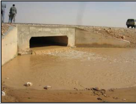
صورة (18): عبارة من فتحة واحدة 5 م × 1 م، طريق جردس الجراري - تناملو، بيئة السروال، أعلى استراحة تناملو، وادي الحليقيمة، رافد الحمامة، الاثنين 22.10.2007
