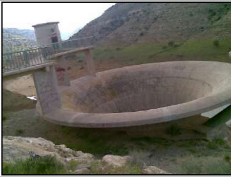
صورة (112): قمع تفريغ الفائض في سد أبو منصور بوادي درنة، هذا القمع لم يعمل منذ إنشائه لعدم وصول منسوب البحيرة لمستواه البالغ حوالي 30 م، تاريخ الصورة 2012..02.03
