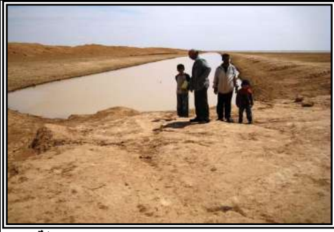
صورة (115): القوض الشمالي من بلطة الرملة، لاحظ انخفاض منسوب مياه القوض بحوالي 1.5 م عن منسوب يوم 04.12.2008، عرض سطح مياه القوض 20 م، تاريخ الصورة، الخميس 07.05.2009
