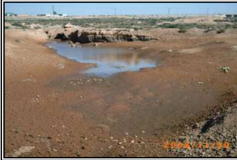
صورة (48): حفرة وادي الرملة، مياه قليلة متبقية بالحفرة بسبب الردم خلال 46 يوم، الحفرة ملنت بمياه جريان 14-15.10.2008، تاريخ الصورة 30.11.2008.
