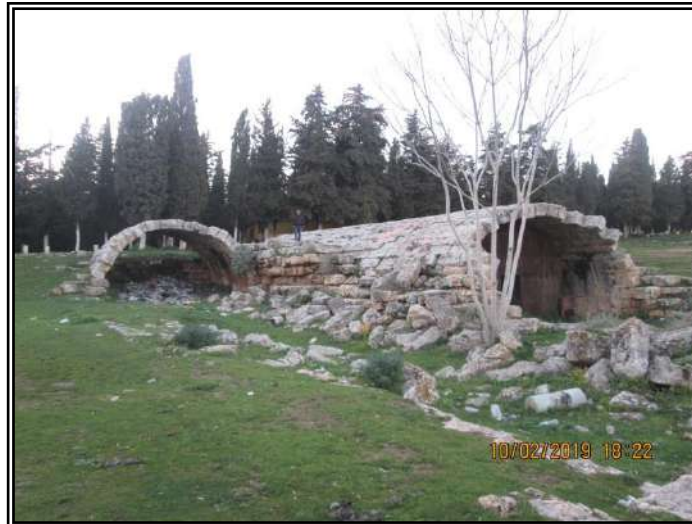
صورة (138): مظهر الخزائين والأكتاف الرابطة بينها والسائدة للجدارين المتجاورة للخزائين المسقوفين في منظومة جمع مياه شحات الأثرية، برفقة عوض عبد الواحد، شحات، الأحد، 10.02.2019، الساعة 18:22.
