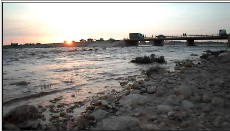
صورة (49): خروج سيل وادي الرملة من عبارة المخيلي، عرض العبارة 50 م، وعمق المياه فيها حوالي 2 م، المخيلي، صورة مقتطعة من فيديو خليفة أمراجع، الأحد 07.06.2015، الساعة حوالي 19:15.
