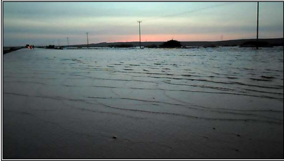
صورة (50): ضخامة جريان سيل وادي القوس من جراء غزارة أمطار الجبهة المحلية فوق السفح الجنوبي للجبل الأخضر، يقطع طريق المخيلي-الخروبة بعرض أكثر من 500 م، رغم وجود عبارة تتكون من 12 فتحة مساحة إجمالي مقطعها يبلغ نحو 18 م 2 ، لم تستوعب غزارة دفقة ذروة الفيضان، غرب المخيلي، صورة مقتطعة من فيديو خليفة أمراج، الأحد 07.06.2015، الساعة حوالي 19:45.
