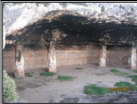
صورة (12): الأعمدة الصخرية في خزان السليط، الأعمدة الثلاثة الموجودة على صف واحد يوازي الضلع الجنوبي الممثل لطول الخزان البالغ 36.6 م، ارتفاع الخزان 4.7 م، وعلام الماء عند امتلاء الخزان بالمياه يبلغ 3.35 م، 08.04.2012.
