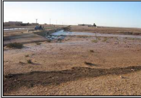
صورة (13): جريان المياه في سلك الحريقة أسفل عبارة المزارع، لاحظ تراكم النفايات العضوية التي تدل على مدى ارتفاع منسوب المياه عند الساعة الثامنة صباحاً، عرض المجرى نحو 150م، وقت الصورة الساعة 15، يوم الثلاثاء 14.10.2008.
