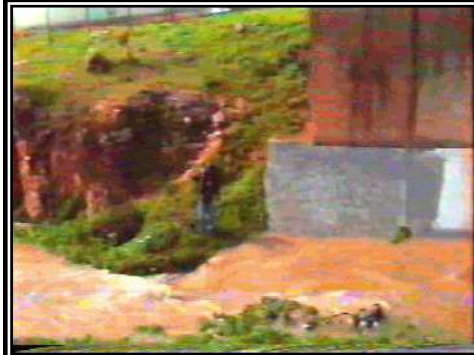
صورة (9): مخرج مياه صرف شوارع المنطقة الجنوبية لمدينة البيضاء من عبارة محطة التنقية، في منطقة الغريقة الواقعة في جنوب شرق البيضاء، قبل وصولها لوادي الكوف، الجمعة 27.03.1998، الساعة 10:15، التصريف 2912 ل/ثا.
