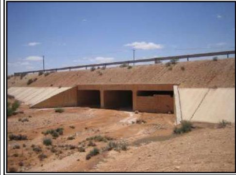
صورة (21): عبارة من ثلاث فتحات الواحدة منها 3م × 2م، غرب وادي الخريف، بيئة السروال، سد العبارة بالبلوك لزرب الحيوانات، الأربعاء 06.06.2007.
