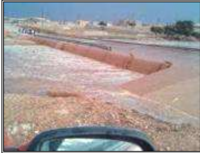
صورة (37): مياه سيل وادي المحجة، الرافد العلوي لوادي الرملة في خولان يفيض على الطريق العام بعرض يزيد عن 100م، عبارة من 3 فتحات 1.5م×1.5م لم تستوعب غزارة الجريان، عن صلاح علي، الساعة 17:08 يوم الأحد 15.11.2015.
