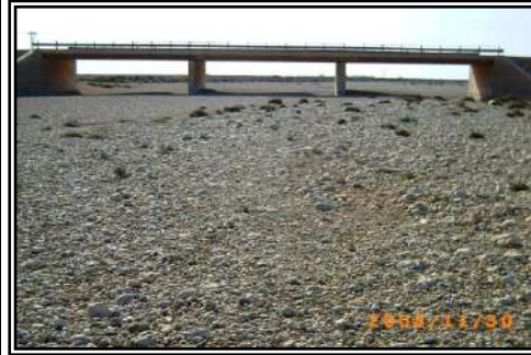
صورة (52): تساوي مستوى الرسوبيات الحصوية تحت عبارة المخيلي وانخفاض قدرة استيعاب العبارة، السروال، وادي الرملة، الأحد 30.11.2008
