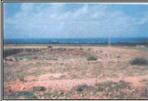
صورة (50): خزان تجميع مياه وادي الشعبة في أعلى السهل الساحلي في ظلمية، شهر 2003/11.
