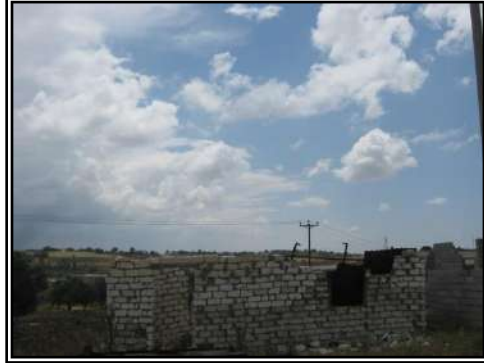
صورة (29): ظهور جبهة رطوبة محلية فوق الصفح الجنوبي للجبلة الأخضر،، جنوب غرب داخلي الجامعة، الثلاثاء 10.06.2014، الساعة 13:08.
