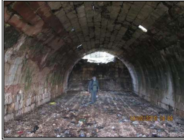
صورة (132): داخل الخزان الشمالي من منظومة الخزانين المسقوفين، لاحظ إحكام بناء الخزان بالحجر الجيري المارني المقصب، البعد بين جداري الخزان 8م، الارتفاع حوالي 6م، الطول المتبقي من الخزان حوالي 35م، لاحظ كيفية توزيع فتحات التهوية على جانبي السقف، الأرضية مردومة، الخطوط التي تظهر على الأرضية ناتجة عن غسل مياه نقط المطر، التي تتسرب من بين خطوط حجارة السقف، للتراب عن حصى الأرضية شحات، الأحد 10.02.2019، الساعة 18:06.
