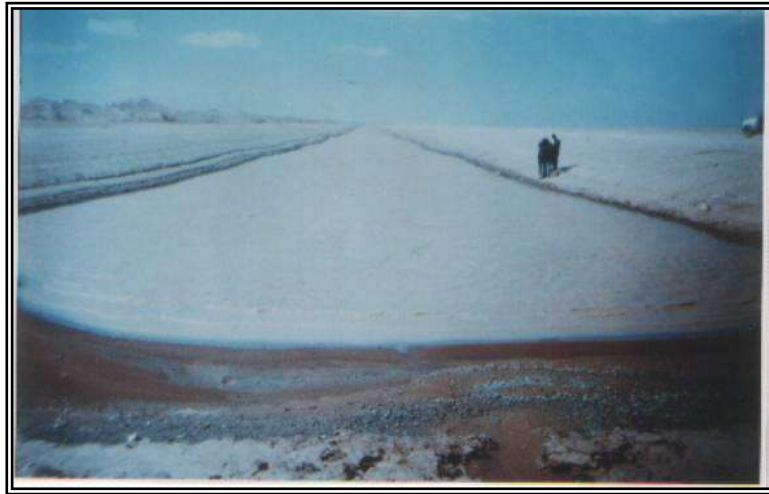
صورة (58): القوض الشمالي في بلطة الرملة اتجاهه شمال-جنوب، حجم المياه فيه 29700 م 3 ، حسب على أساس أن طول القوض 1000 م، عرض سطح مياه القوض 16 م، وعرض قاعدة القوض 6 م. وعليه يبلغ سمك طبقة المياه بالقوض 2.7 م، بتاريخ 03.03.2000.
