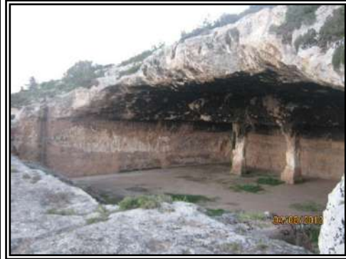
صورة (9): خزان السليط الزاوية الجنوبية الشرقية، الضلع الشرقي الممثل لعرض الخزان يساوي 28.9 م، ويظهر في طرفه الشمالي أثر المياه الوارد من قناة التغذية الشرقية للخزان، 08.04.2012.
