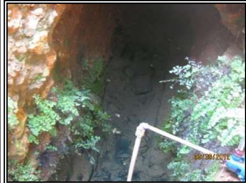
صورة (99): فجارة المنشية في القيقب في مزرعة الحاج عمر يونس، لاحظ القناة في الوسط، وممر مشاة على اليمين واليسار بعرض 30 سم لكل منهما، المسافة المستكشفة من الفجارة 30م فقط من طول حوالي 2 كم مردوم، عمق المياه في قناة الفجارة 103 سم، الاتجاه جنوب شرق-شمال غرب، 30.03.2012.
