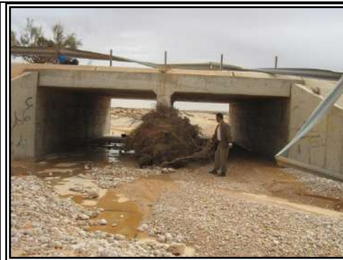
صورة (32): أشجار السدر التي يجلبها الجريان تسد العبارات الكبيرة 4م×3م، وتخریب الحماية الخرسانية لجوانب الطريق العام في وادي الحمامة، بينة السروال، الجمعة 19.10.2007.
