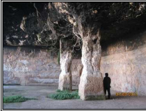
صورة (10): تدهور حالة الأعمدة، 135 سم × 120 سم، والارتفاع 470 سم، في خزان السليط، 08.04.2012.
