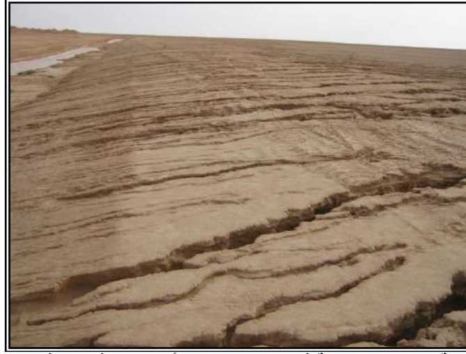
صورة (5): فعالية التشققات الطينية في تنشيط النحت الأخدودي وفعاليته في تعميق المجاري نتيجة تسرب المياه في مواد طين أرضية البلطة من جراء جريان 02.02.2014 على الجانب الغربي للطرف الشمالي للقض الجديد الثاني في وسط بلطة الرملة الغربية، الاثنين 21.04.2014.
