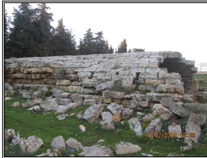
صورة (136): مظهر جانبي للخزان الحجري المسقوف من الخارج من الزاوية الجنوبية الشرقية، حالة الخراب التي تعرضت لها الخزانات الحجرية المسقوفة في منظومة جمع مياه شحات الأثرية نتيجة تطاول زمن الإهمال لهذه المنظومة الفريدة، لاحظ منسوب فتحات تمرير المياه بين الخزائين تحت منسوب الأكتاف، شحات، الأحد 10.02.2019، الساعة 18:09.
