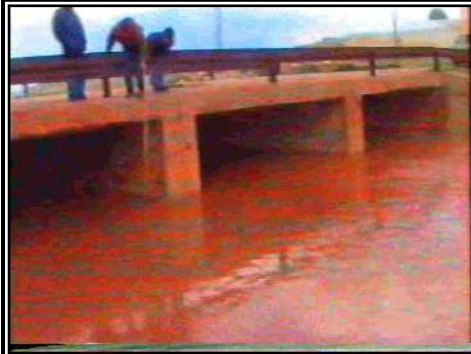
صورة (26): وادي الجديد في زاوية الحمامة، الجمعة، 27.03.1998. الساعة 15:15، التصريف 3.2584 م 3 /ثا، التصريف النوعي 47.7 ل/ثا/كم 2 ، مساحة الحوض 68 كم 2 .
