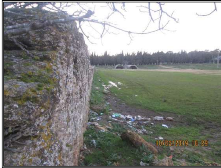
صورة (123): الزاوية الجنوبية الشرقية للخزان الكبير المكشوف من منظومة مياه شحات الأثرية، لاحظ فساحة فضاء الخزان الذي تظهر في وسطه عند الطرف الغربي البعيد منظومة الخزائين المسقوفين المبنيين بالحجر المقصب وفق مقطع عرضي قوسي نصف دائري، شحات، الأحد 10.02.2019، الساعة 18:29.
