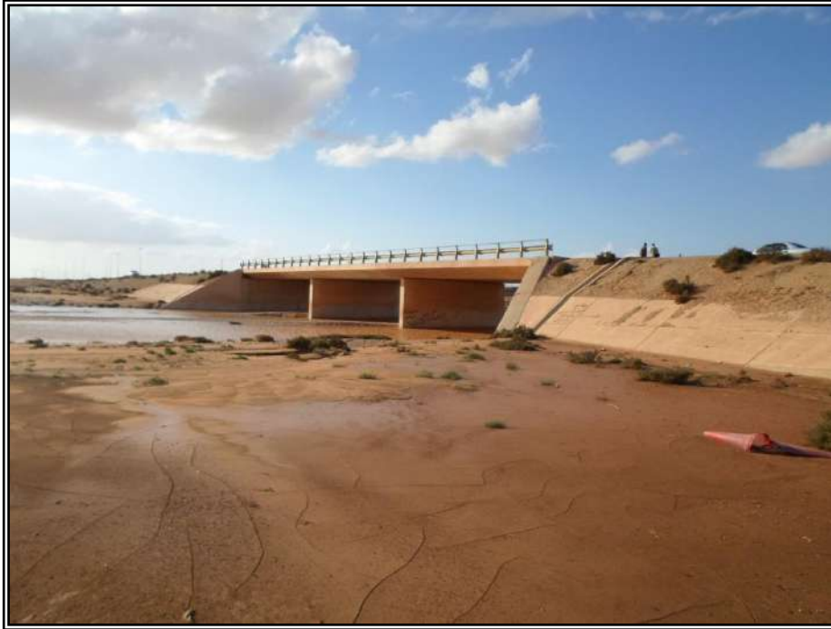
صورة (23): آثار جريان الأمس، الاثنين، الواضح في الصورة، بلغ على الجدار الشرقي للعبارة 140 سم فوق منسوبه الحالي الظاهر في الصورة، سرعة الجريان الحالي 51م/52 ثا، ومن ثم قدرت الغزارة الحالية بنحو 10م 3 /ثا، غزارة الأمس يمكن تقديرها على النحو التالي: عرض العبارة 50 م × 1.4 م = 70 م 2 ، سرعة ذروة الفيضان في العبارة على الأقل تساوي 4 أضعاف السرعة الحالية وعليه فالغزارة تقدر بنحو: 70 م 2 × 4 م/ثا = 280 م 3 /ثا، وادي الرملة، عبارة المخيلي، الثلاثاء 03.11.2015، الساعة 15:44.
