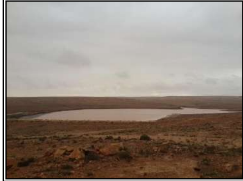
صورة (13): سد الدواي متخّم بالمياه، حوالي 620000م 3 ، ويزود بمياه السيل في وقت زيارته، والفائض عن استيعاب البحيرة يخرج من المصرف الجانبي لبحيرة السد، سد الدواي، الثلاثاء 03.11.2015، الساعة 12:07.
