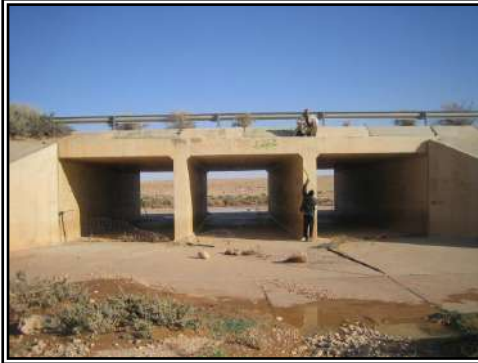
صورة (24): عبارة من ثلاث فتحات الواحدة منها 4م × 3م، بيئة السروال، وادي تناملو العبارة الغربية، الأربعاء 06.06.2007.
