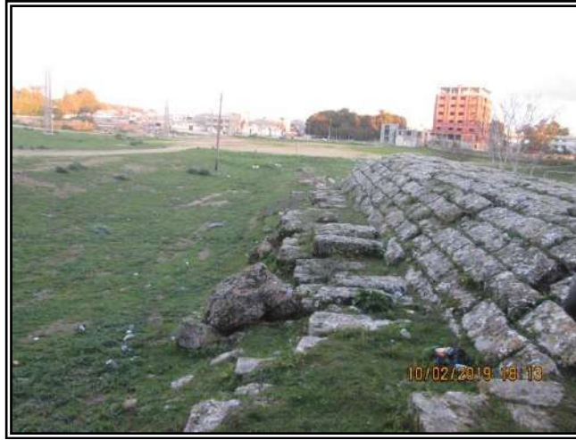
صورة (139): الكتف الحجري الجانبي السائد للجدار الشمالي للخزان المسقوف الشمالي من منظومة الخزائين الحجريين المسقوفين من منظومة جمع مياه شحات الأثرية، لا حظ منسوب التربة المجاورة لجدار الخزان التي يأتي منها رشح المياه عبر الجدار نحو داخل الخزان، شحات، الأحد، 10.02.2019 الساعة 18:13.
