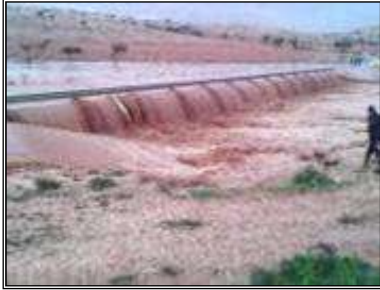
صورة (38): مياه سيل وادي الرملة، يجمع الفارغ والمحجة في عبارة خولان السفلى، المياه تفيض على الطريق العام بعرض يزيد عن 100م، 9 فتحات 2.2م×1.5م لم تستوعب غزارة الجريان، عن صلاح علي، الساعة 17:25 الأحد 15.11.2015.
