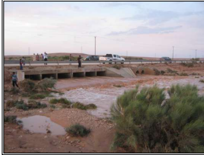
صورة (23): سيل وادي القوس، مياه ذروة الفيضان لم تستوعبها العبارة المولفة من 12 فتحة، لذلك تجاوزت مياه السيل الطريق العام المخيلي-الخروية على طول أكثر من 400م، كما تدل آثار الجريان والرواسب على الطريق، الاثنين 09.06.2014، الساعة 19:15، وبحسب ما يفيد الأهالي: أوقفت حركة السيارات ما بين الساعة 14:30 وحتى الساعة 16:00.
