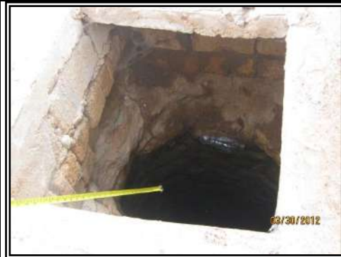
صورة (89): عمق سطح المياه في المعاطن في خولان يصل لمنسوب سطح الأرض تقريباً، 30.03.2012.
