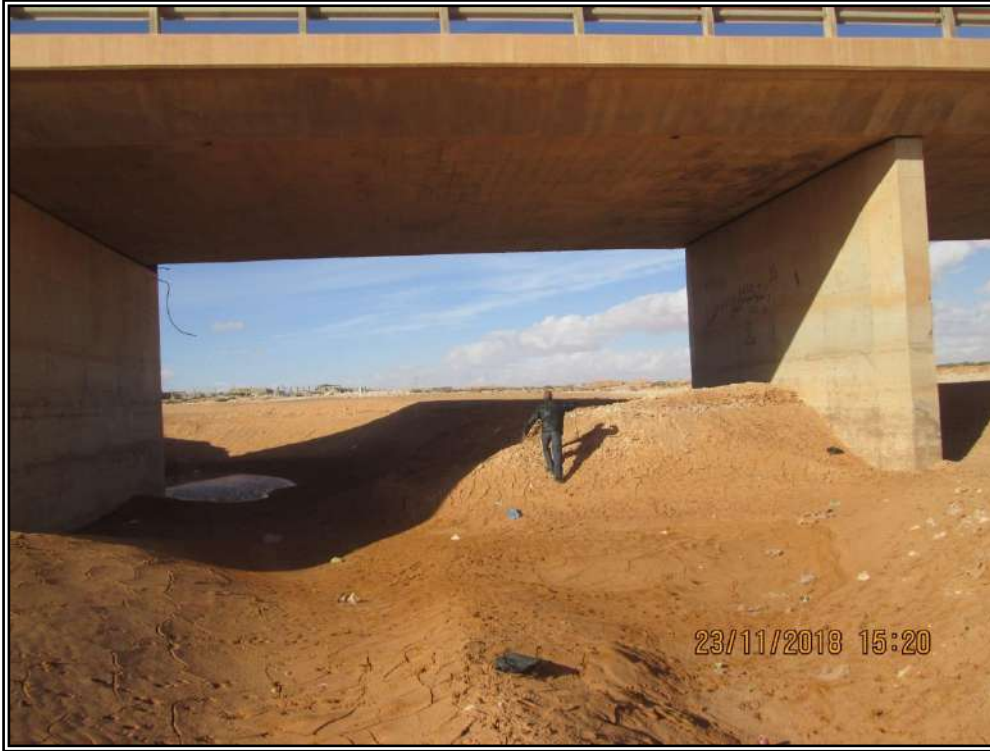
صورة (147): مخرج الفتحة الغربية من عبارة المخيلي، ارتفاع جدار الجناح الغربي، للفتحة الغربية، على يسار الصورة 6 م، المنسوب العلوي على اليمين أي خلف خليفة أمراجع 4 م، وفي الوسط 5 م، عرض الفتحة الواحدة حوالي 16.5 م، الجمعة، 23.11.2018، الساعة 15:20.
