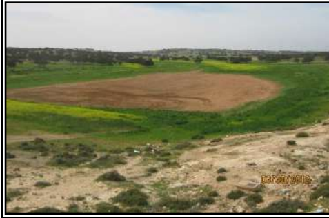
صورة (104): سد المحجة جنوب شرق أشنيشن لاحظ بقعة أثر المياه لآخر جريان من موسم 2011-2012، التاريخ 30.03.2012.
