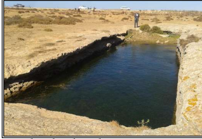
صورة (117): خزان جمع مياه من رشح طبقة صخرية جيرية مارنية تزود الخزان بالمياه الجوفية السطحية، طول الخزان باتجاه غرب-شرق حوالي 25م العرض حوالي 6م عمق المياه تتراوح ما بين 0.5م و1.2م بحسب الفصل من العام، عمق المياه في وقت الزيارة حوالي 0.7م، رغم أن الخزان قد يتزود من مياه سيل محلي، لكنه يجمع مياه الرشح على طول العام، يمين طريق الأبرق-القيقب، أرض عبد السلام عبد الجواد الجمعة 21.06.2013، الساعة 16:29.
