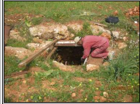
صورة (97): فجارة القيقب العمق 4.5 م، عمق المياه 1.03م، عرض قناة الفجارة 70 سم، عرض الفجارة 1.3م، فتحة البربخ 1.5م × 1.5م، الإنتاجية حوالي 1 ل/ثا، بتاريخ 30.03.2012.
