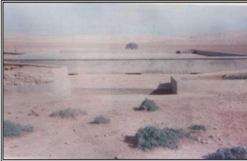
صورة (29): بئر باحة مدرسة الكرم والخليطة الذي يجمع مياه السفح الجنوبي من المدرسة، لاحظ بركة الترقيد في مقدمة البئر، عام 2000.
