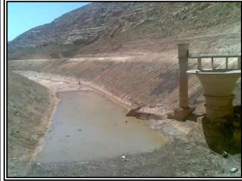
صورة (113): سد وادي درنة السفلي، (سد البلاد) السد إسمنتي وقائي يجمع مياه، وعمل فيه قمع التفريغ لأكثر من مرة وكتمت بحيرة السد بالإسمنت، لكن عملية التكتيم لم تكن فعالة، تصوير زهران الرواشدة، 19.04.3012.
