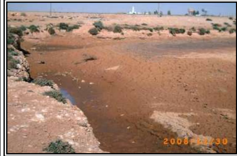
صورة (47): حفرة اصطناعية معترضة على أحد فروع وادي الرملة على المروحة الإرسابية في المخيلي، لاحظ حجم ردميات الطمي، 30.11.2008.
