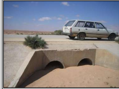
صورة (33): انسداد شبه كامل للعبارات بالرمل غرب المخيلي بنحو 6 كم، الأربعاء 06.06.2007.
