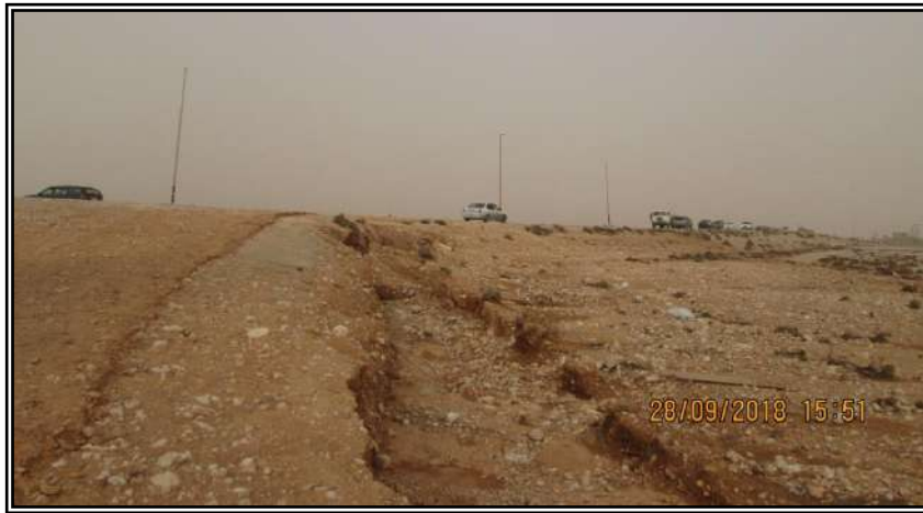
صورة (105): تهديد جوانب الطريق العام والطرق المحلية المتفرعة عنه، بفعل تجاوز مياه الفيضان لأجسام الطرق وانحدارها العنيف على الجانب الجنوبي، حيث ينشط النحت الرأسى، غرب عبارة المخيلي، الجمعة، 28.09.2018، الساعة 15:51.
