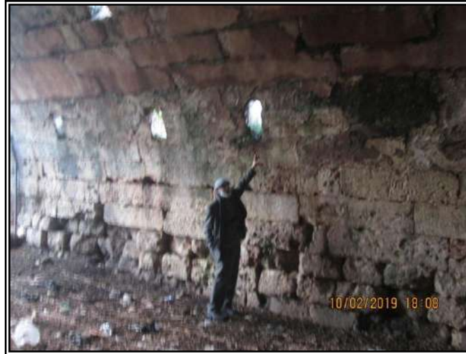
صورة (135): منسوب سفلي لفتحات تمرير الماء في الأسفل ارتفاعه عن منسوب الأرض الحالية حوالي 220سم، وفتحات التهوية في منسوب أعلى داخل الخزان المسقوف الشمالي، والتي ربما كانت تمثل مأخذ للمياه من الخزان، شحات، الأحد 10.02.2019، الساعة 18:08.
