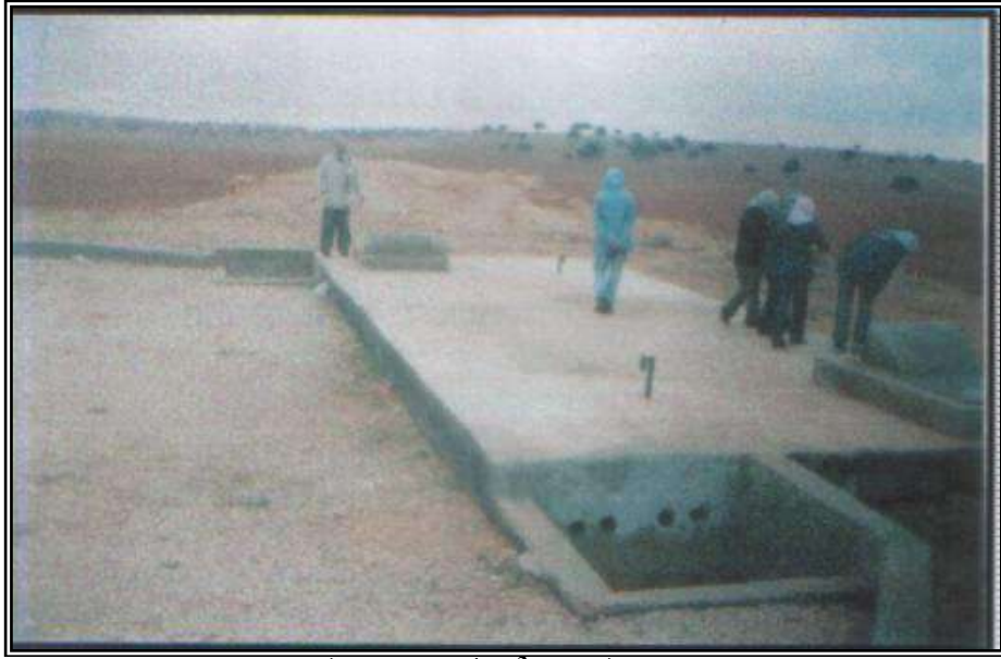
صورة (30): بئر سماء إسمنتي سعة 100م 3 ، الأبعاد الخارجية: الطول 11م، العرض 4.7م، إنجاز مجموعة الغطاء النباتي بعد سنة 2000، منطقة الجورة، شهر 11. 2005.
