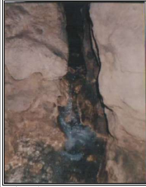
صورة (96): إحدى العيون الجانبية بنفق أبو منصور بوادي درنه، العين تخرج من صدع عرضه حوالي 15 سم محشو بمواد التربة التي تجلبها المياه والجاذبية الأرضية من سطح الأرض، 1998.
