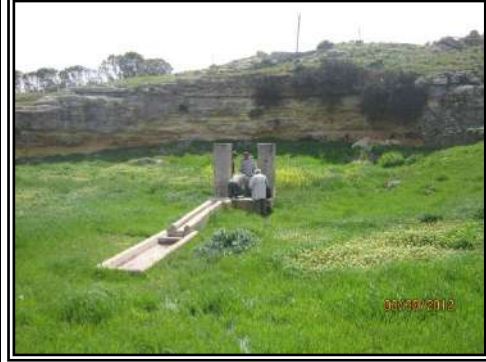
صورة (91): معطن سيدي الحمري، عمق منسوب المياه 1.7 م تحت سطح الأرض بتاريخ 30.03.2012.
