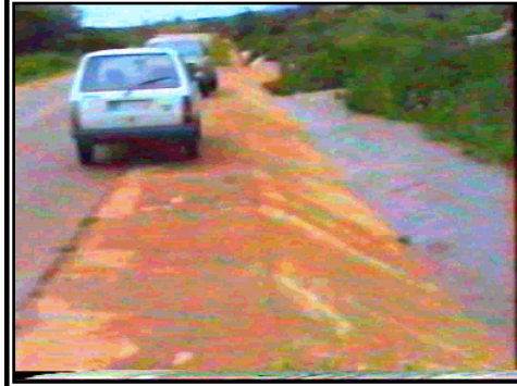
صورة (23): الرافد العلوي لوادي الجديد (أم كراع)، اسم الرافد وادي زيدان، محطة القياس الوسيطة، طريق الوسيطة-المنصورة، الارتفاع الطبوغرافي 475.8 م، المجرى أنبوبين قطر كل منهما 1 م، التصريف 677.2 ل/ثا، الجمعة 27.03.1998، الساعة 18:00.
