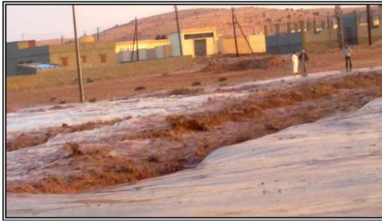
صورة (24): مياه سيل وادي المحجة تفيض على الطريق العام وتغمر عبارة خولان بأكثر من 60سم لتغمر الحديد الواقى الجانبي للطريق، التصريف نحو 100 م 3 /ثا، هذه المياه ترقد سيل وادي الرملة المتجه نحو بلطة الرملة، ، لقطة من فيديو، عن عبد السلام المدفع، الساعة 16:00، يوم الثلاثاء 10.06.2014.
