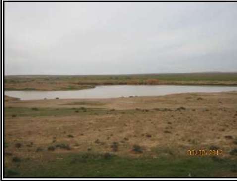
صورة (36): لوحظ بقاء مياه حفرة أبو علي الاصطناعية حتى 07.05.2009 مع العلم أنها ملئت في 14.10.2008، أي أنها تمسك بالمياه لفترة 206 أيام في الشتاء والربيع، 30.03.2012
