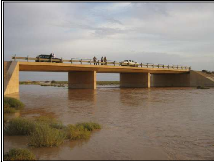
صورة (11): مياه سيل وادي الرملة في عبارة المخيلي متجهة نحو بلطة الرملة، عرض العبارة 50 م، غزارة السيل حوالي 80 م 3 /ثا، الساعة 18:49، يوم الاثنين 09.06.2014.
