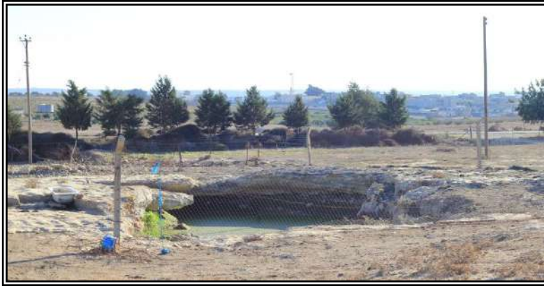
صورة (115): خزان مياه بجمع مياه منسوب المياه الجوفية من الطبقة الصخرية الجيرية المارنية تحت السطحية على عمق نحو 2م تحت سطح الأرض، وتستخدم مياهه في تغذية الحيوانات وتربية البط، ويخدم المنزل المجاور، شرق قرنادة، على يسار الطريق الواصل بين قرنادة وطريق الأبرق-القيقب، مزرعة منعم أبو نايف، الثلاثاء 13.10.2015، الساعة 16:15.
