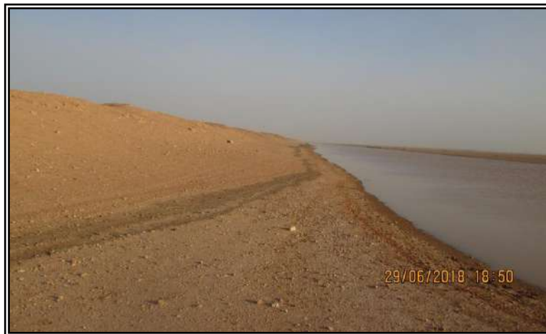
صورة (75): أثر الرسوبيات من الزيل والنفايات العضوية (العدوة) على الردميات الموجودة على يسار القض الشمالي تبين المنسوب الذي بلغته مياه البلطة من جراء الفيضان من جهة، وسرعة تراجع منسوب مياه البلطة خلال ثمانية أيام فقط من جهة ثانية، وذلك بفعل امتصاص طين أرضية البلطة للمياه، وبفعل التبخر النشط في الصيف، ليصبح منسوب المياه على ما هو عليه في القض الشمالي، بلطة الرملة الغربية، الجمعة، 29.06.2018، الساعة 18:50.
