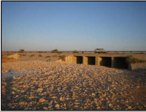
صورة (26): عبارة من أربع فتحات الواحدة منها 4م×3م، وادي الحمامة؛ العبارة الغربية، بيئة السروال، تهديد العبارة بالانسداد بالحجارة، الأربعاء 06.06.2007.
