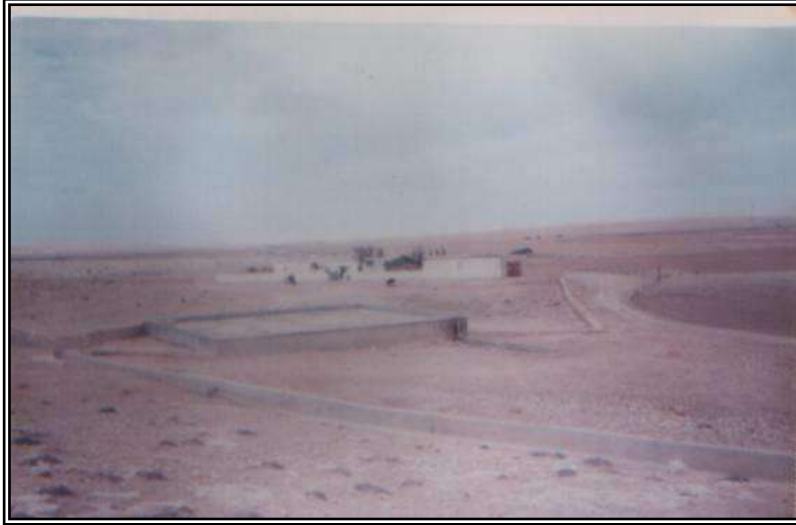
صورة (28): بئر سماء مدرسة الكرم والخليطة على يسار طريق مراوة- ذروة، يتكون هذا النظام من البئر القريب من الناظر والذي يقع في باحة المدرسة والبئر الثاني يقع ضمن بناء المدرسة، وفائض المياه من بئر الباحة يسيل ليملاً بئر المدرسة الذي يستمد المياه من سطح المدرسة أيضاً، وعليه فهذا البئر يتمتع بأفضل إدارة مائية لآبار السماء في الجبل الأخضر، عام 2000.
